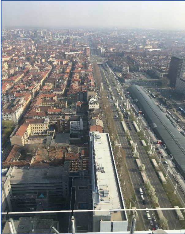
Abb. 7.: Blick vom Skyscraper Grattaciolo Intesa Sanpaolo (2014) auf den neuen Tunnelbahnhof Porta Susa von Turin (2008/2013) mit 300 m langer Stahl- und Glaskonstruktion
